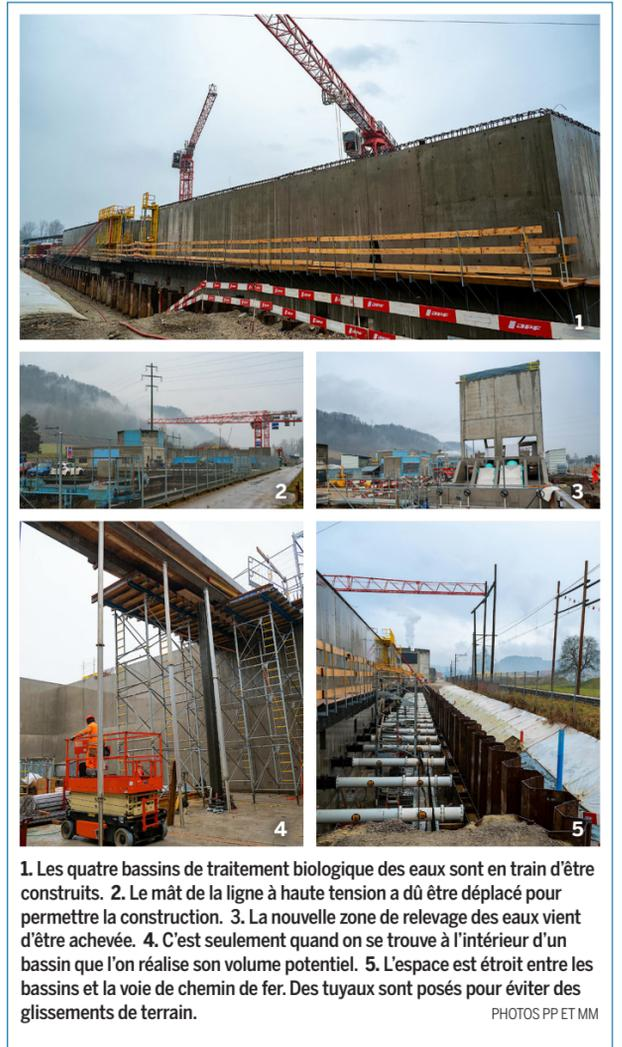
1. Les quatre bassins de traitement biologique des eaux sont en train d'être construits. 2. Le mat de la ligne à haute tension a dû être déplacé pour permettre la construction. 3. La nouvelle zone de relevage des eaux vient d'être achevée. 4. C'est seulement quand on se trouve à l'intérieur d'un bassin que l'on réalise son volume potentiel. 5. L'espace est étroit entre les bassins et la voie de chemin de fer. Des tuyaux sont posés pour éviter des glissements de terrain. PHOTOS PP ET MM
